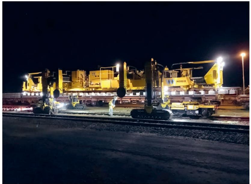
Das Ein- und Ausgleisen sowie das Verladen der Trolleys erledigt der Tracklayer.
