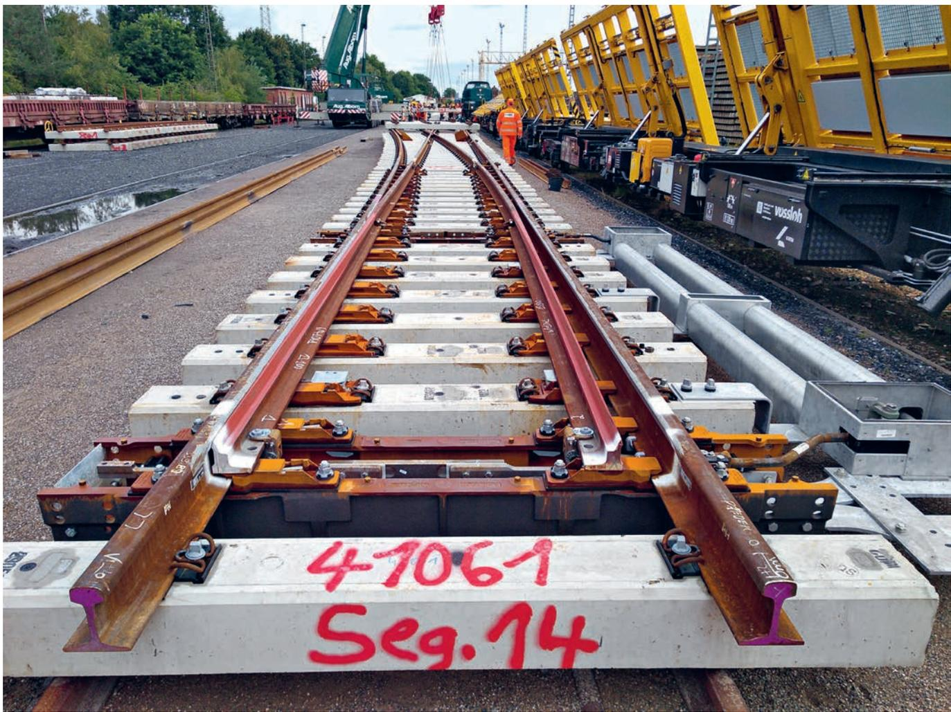
Durch die Komplettmontage und die Erprobung der Weichen im Weichenwerk, den sicheren Transport und das schonende Handling wird eine signifikant höhere Präzision und Qualität der verlegten Weiche erreicht. Das senkt Betriebskosten und verlängert die Lebensdauer der Weichen.
