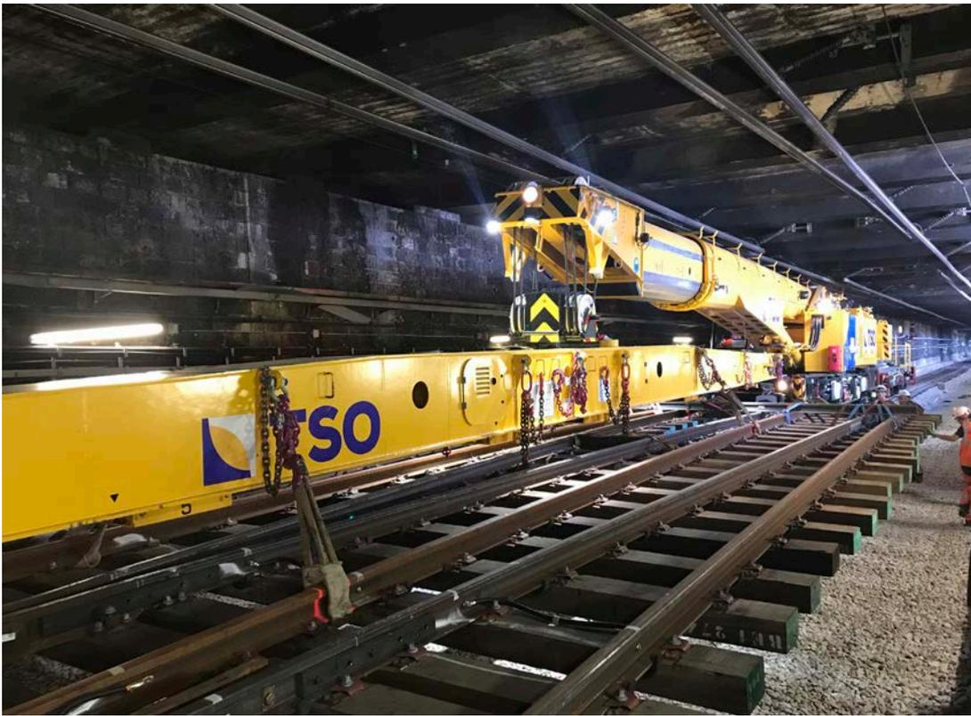
Lastpositionierung mit dem Self-Levelling Beam
