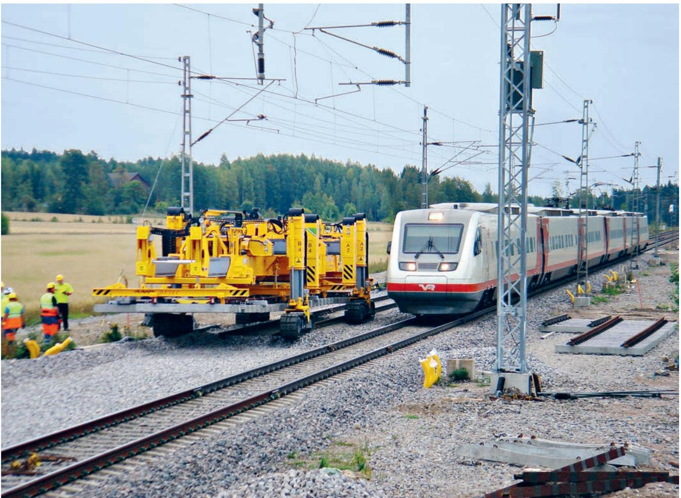
Benachbarte Gleise können auch während der Bauphasen befahren werden. Die Beeinträchtigung des Zugverkehrs und die damit verbundenen Betriebserschwerungskosten werden minimiert.
