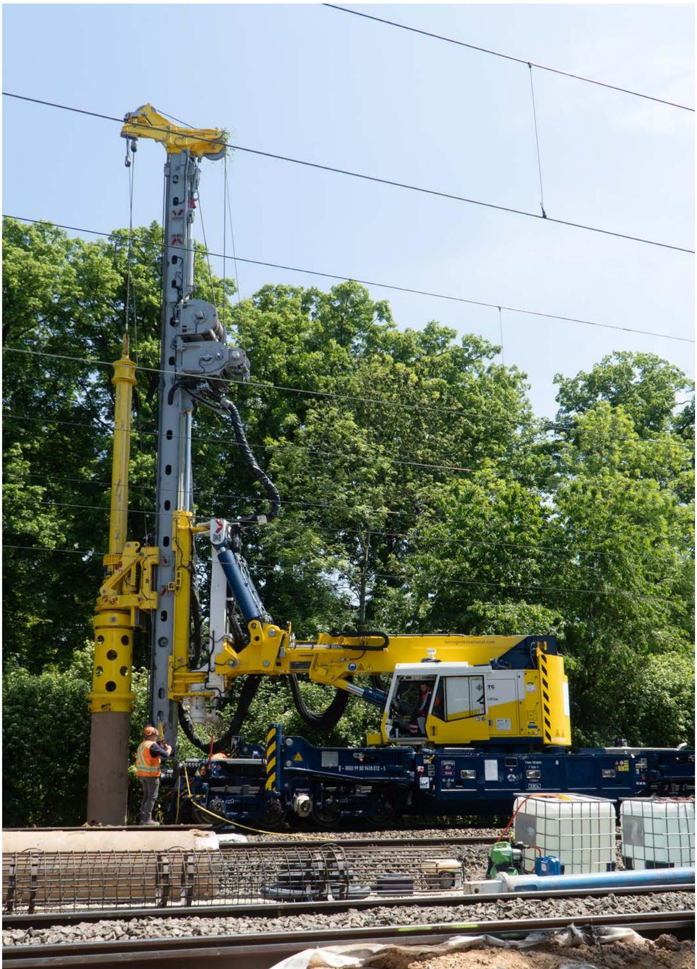
Der GGZ ist ein schienenengebundenes Spezialfahrzeug, das aufgrund hoher Ausladungen und hoher Leistungsfähigkeit Gründungsarten und -tiefen ermöglicht, welche vormals am Gleis nur mit erheblichem Aufwand möglich waren.
