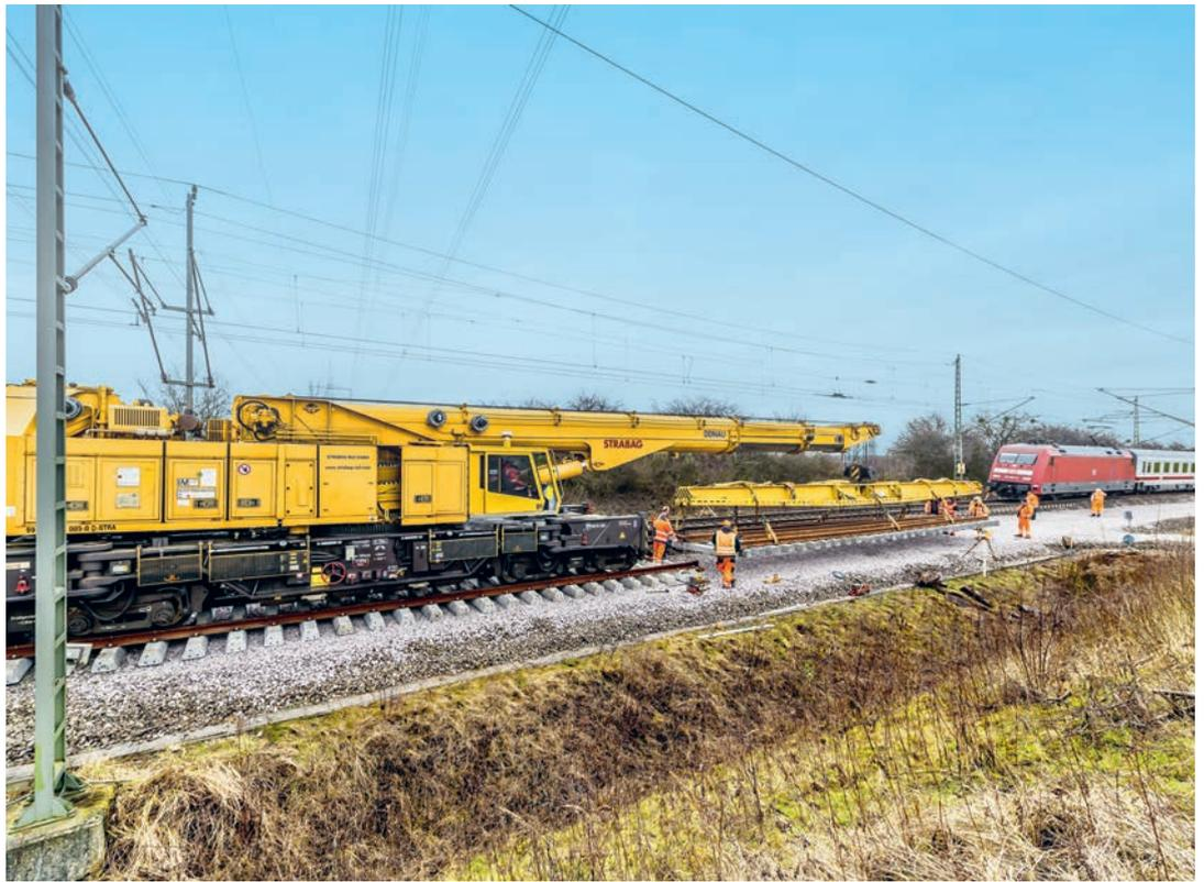
Bauen und Fahren. Der Multi Tasker ermöglicht Zugverkehr auf dem Nachbargleis.
