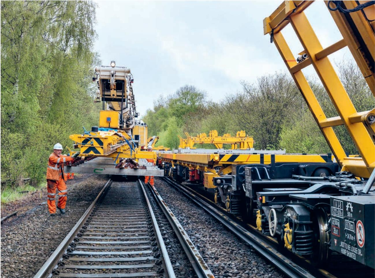
Die Kombination des Multi Taskers oder Tracklayers mit dem Weichenwagen minimiert den Ressourcenverbrauch. Die Montage der Weichenmodule erfolgt in den Weichenwerken mit elektrisch angetriebenen Kranen. Der Transport erfolgt umweltfreundlich über die Schiene.
