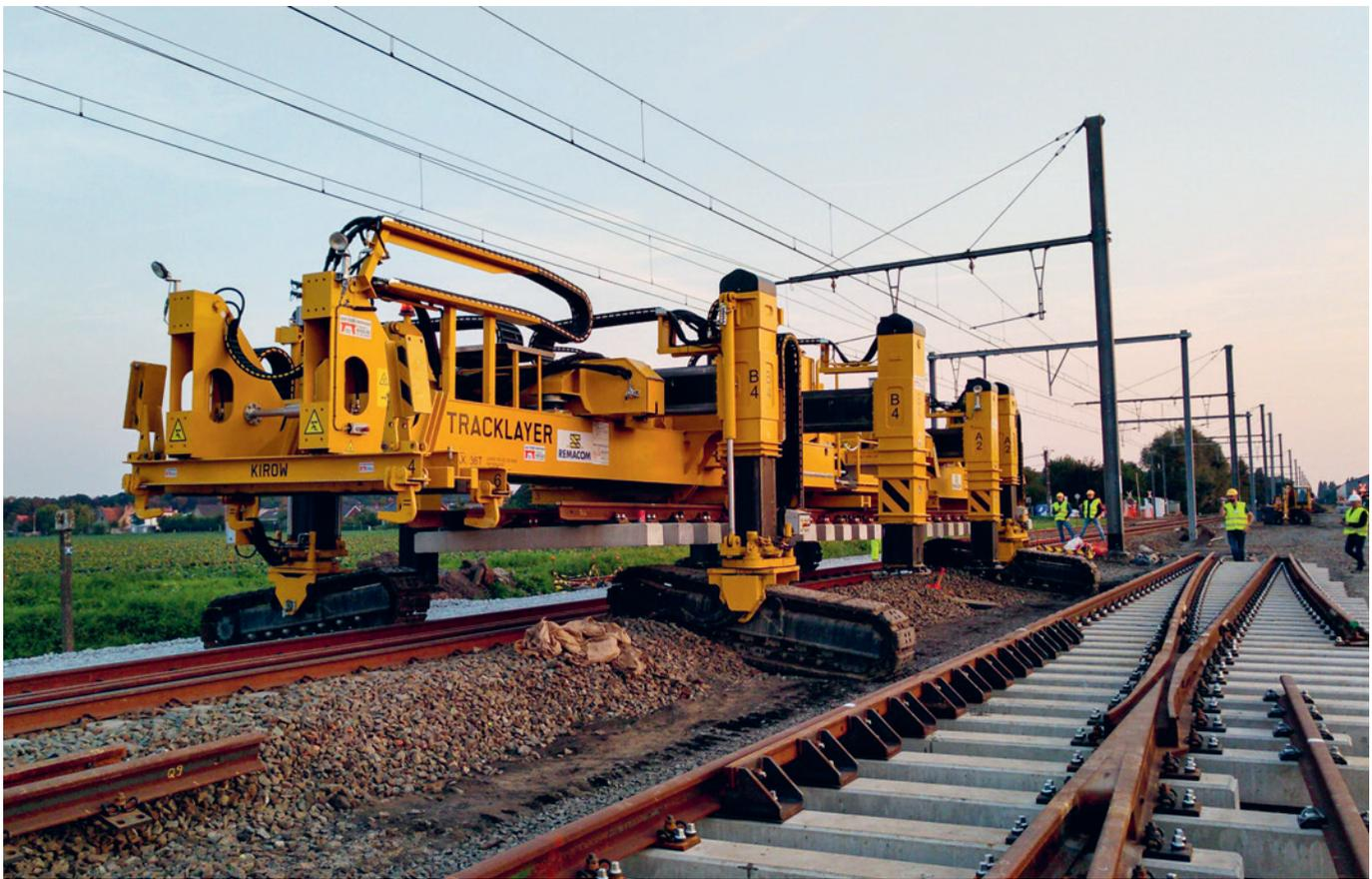
Der Tracklayer ist ein Multifunktionsgerät für das Heben, Transportieren und Verlegen von sehr langen und schweren Gleis- und Weichenteilen.
