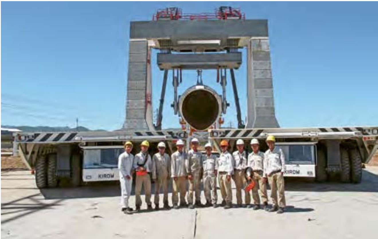
Inbetriebnahme von Kranwagen und Multi Mover in Indonesien / Putting the Yardcrane and the Multi Mover into operation in Indonesia
