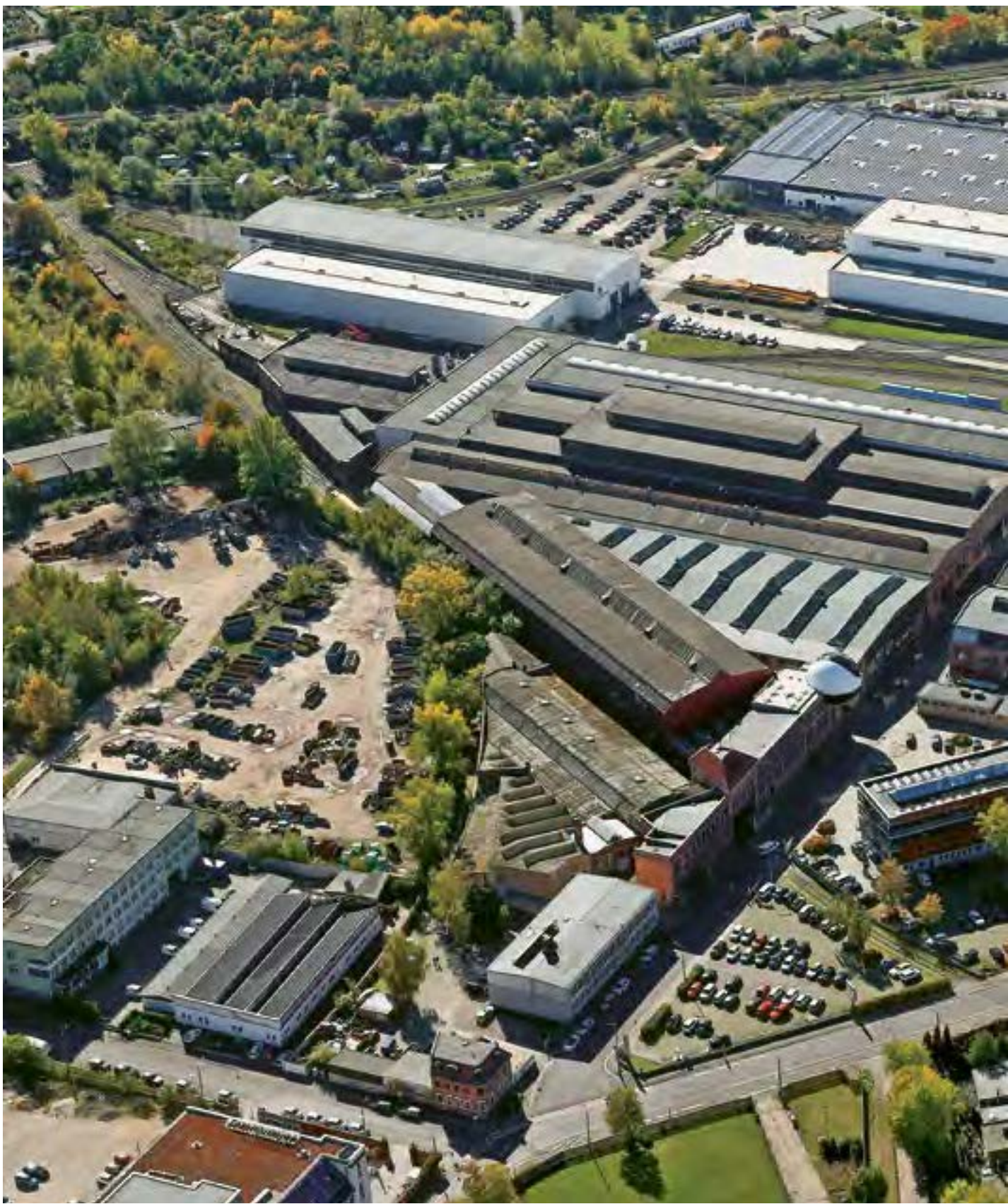
Techne Kirow Werk mit technischem Entwicklungszentrum, Montage- und Stahlbauhallen sowie Testfeld und Oscar Niemeyer Sphere / Techne Kirow works with design center, assembly and steel structure fabrication halls, test field and Oscar Niemeyer Sphere
