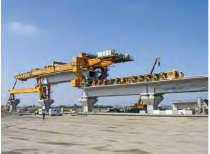
Verlegung des Betonträgers / Installing the concrete beam
