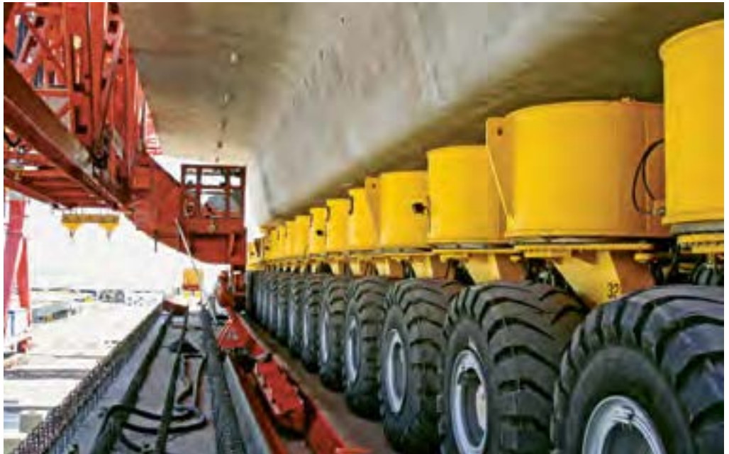
Der Multi Mover C 900 mit Betonträger / Multi Mover C 900 with a concrete girder
